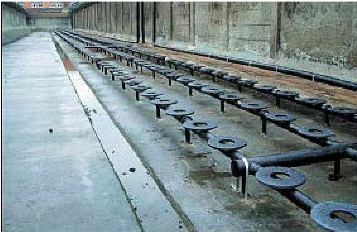
Аэрационная система АКВА-ТОР-М на Курьяновских очистных сооружениях (г. Москва)
