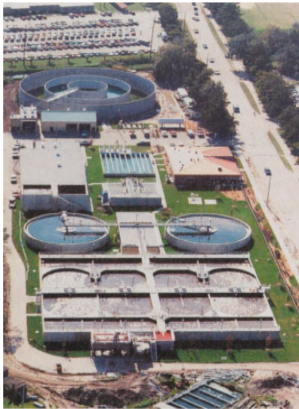
СООРУЖЕНИЯ ПО ОЧИСТКЕ СТОКОВ УНИВЕРСИТЕТА ФЛОРИДЫ, США
